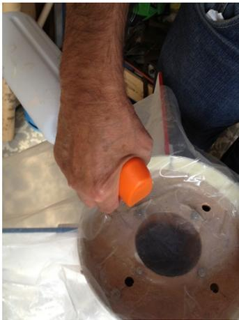
Rociando con agua el interior de los huecos para que se pegue la espuma de PU.
