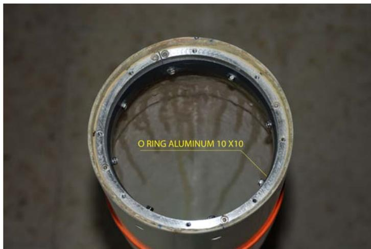
Fig. 47 Anillo de fijación de la tapa.
